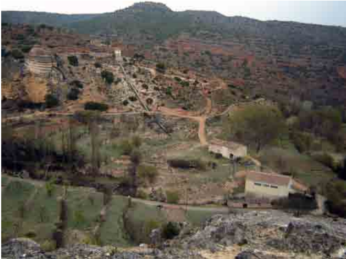
Central Eléctrica de Castielfabib (Foto de Salvador F. Cava)
